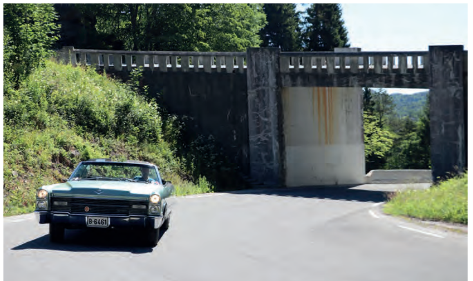
Vel inne i Telemark gikk den gamle veien innom Langangen. Her var Sørlandske hovedvei grusvei til langt innpå 1950-tallet. Fra Langangen må veien klatre 110 meter opp i terrenget på en strekning på 450 meter, et gjennomsnittlig stigningsforhold på 1:4. Derfor bygde man veien allerede i 1865 slik at den krysset seg selv. Det er Arild Günther fra Moss som kjører sin Cadillac DeVille fra 1966 under «svingbrua» som i nyeste utgave sto ferdig i 1941. Først 13 år etter at denne bilen var ny, i 1979, kom den nye E18 som går i to høye bruer over Langangen.
