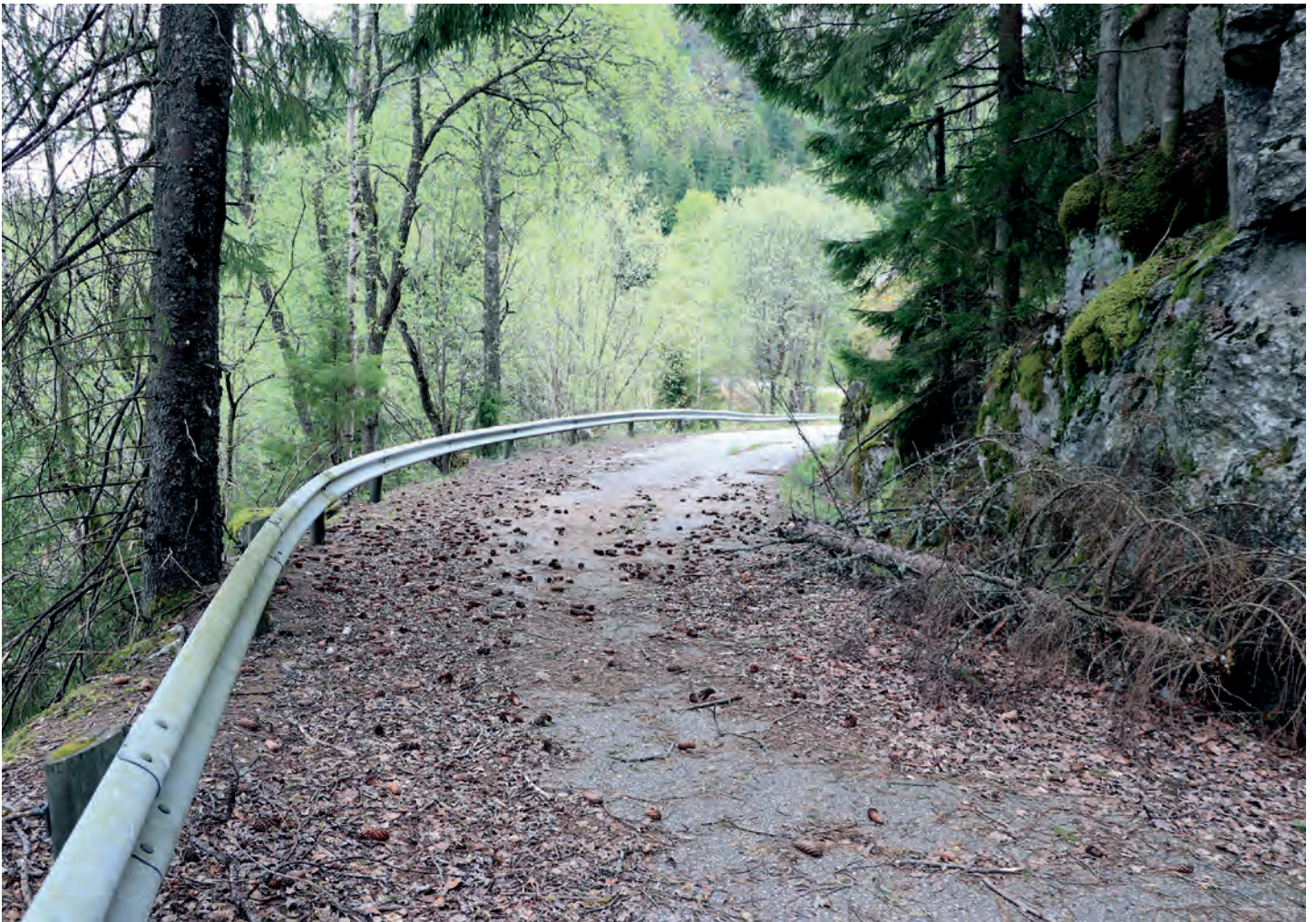
Her er vi i Larvik kommune en kilometer før fylkesgrensa til Telemark. Denne veien – som sto ferdig i 1861 - var Riksvei 40 inntil 1962. Akkurat her er veibredden som den var i 1861 da standard veibredde var 7 alen (4.2 meter). Ikke så greit for to lastebiler å møtes her så sent som i 1962. Nå er veien stengt i begge ender, men den var åpen som lokalvei inntil for et par år siden. Forfallet skjer fort.
